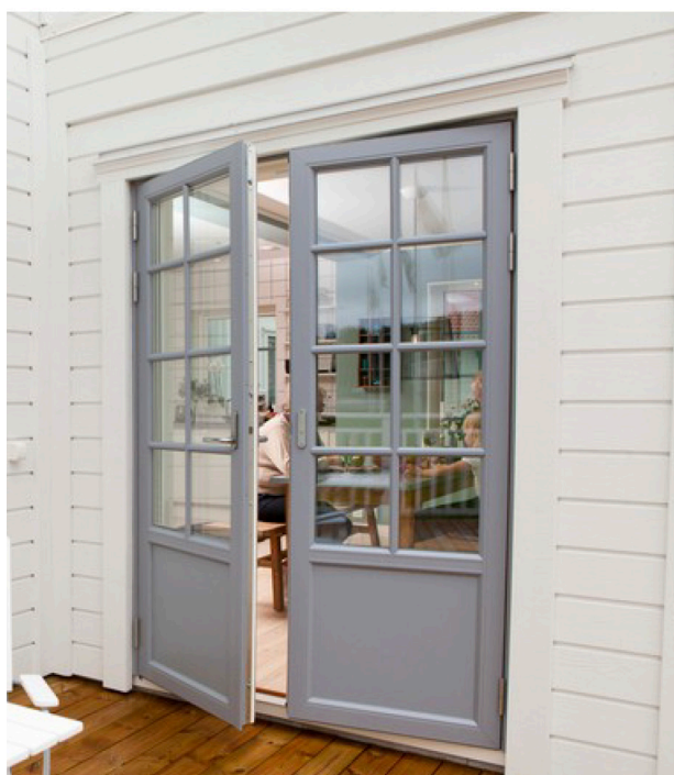
Fönsterdörr av pardörrsmodell med speglar under de spröjsade fönstren.
