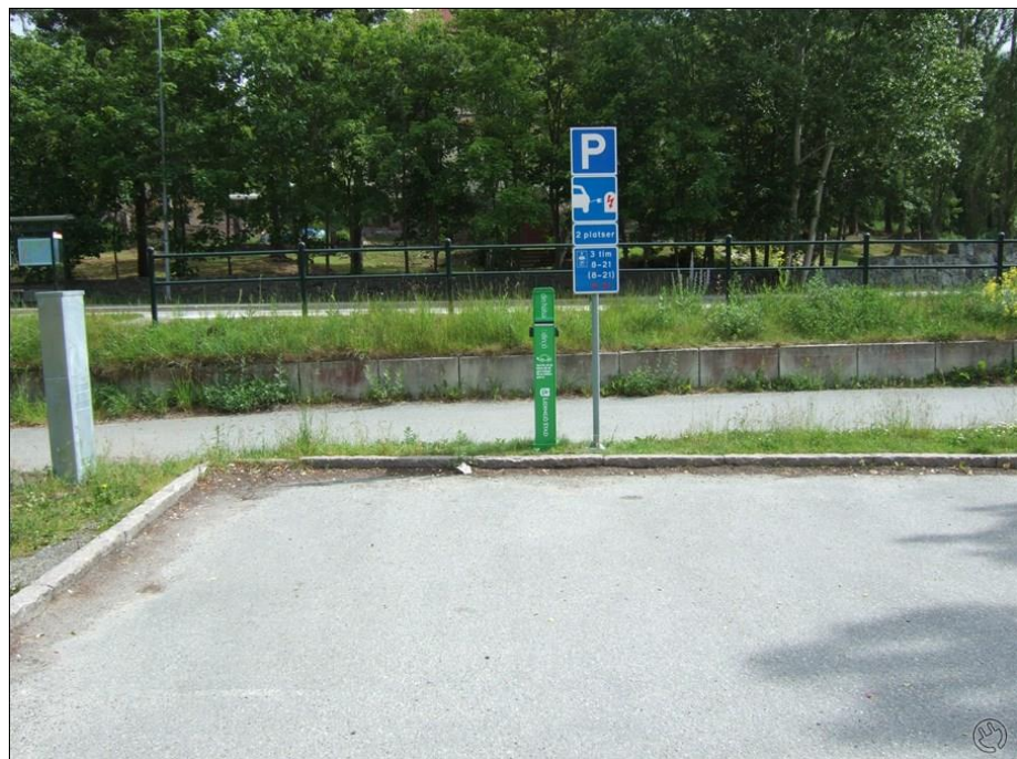
Bild 12 Bilden visar laddplats (destinationsladdning) på Friggavägen, Lidingö. Här kan man ladda med 11 kW (Typ 2-kontakt) och laddning sker gratis. Uppställningstiden är begränsad till 3 timmar med P-skiva alla dagar kl. 8-21. Övrig tid kan laddning ske utan tidsbegränsning. Källa: www.uppladdning.nu
